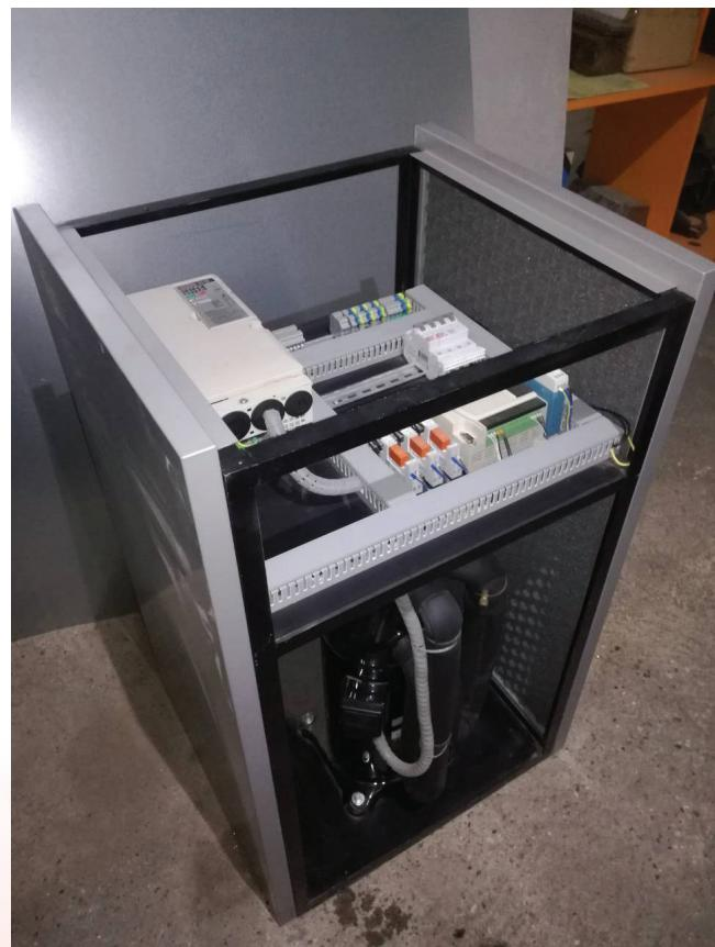
Dvostrukim odvajanjem kompresora od kućišta toplotne pumpe izbjegnut je prenos vibracija pa smo dobili vrlo tih proizvod.
